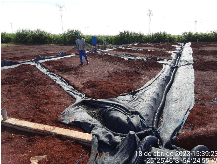
2ª MD – FOTO 05 – SERVIÇO DE INSTALAÇÃO DA IMPERMEABILIZAÇÃO
