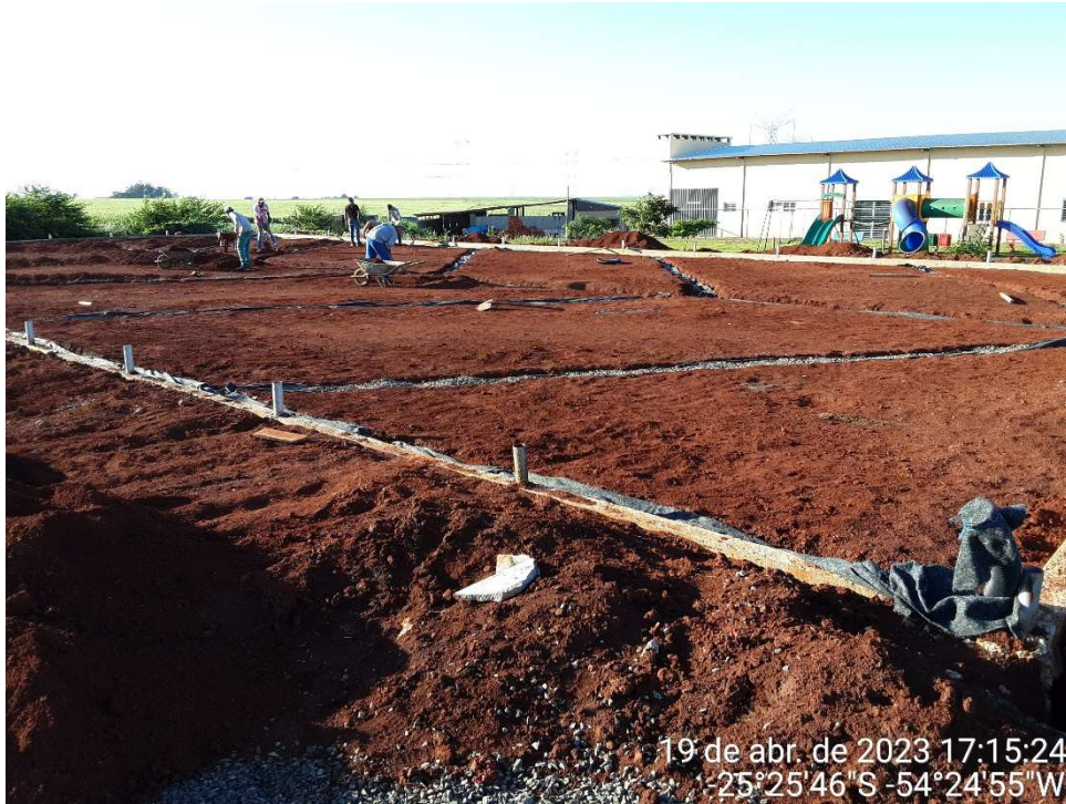
2ª MD - FOTO 03 – SERVIÇO DE INSTALAÇÃO DO SISTEMA DE DRENAGEM
