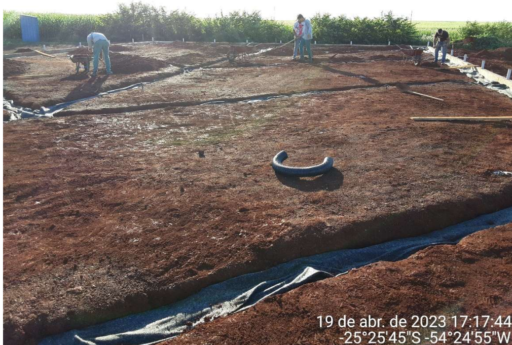
2ª MD - FOTO 02 - INSTALAÇÃO DO SISTEMA DE DRENAGEM
