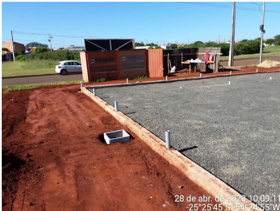
2ª MD – FOTO 12 – CANTEIRO DE OBRAS CONTEINER-TUBOS GALVANIZADOS- ESPERA DO ALAMBRADO
