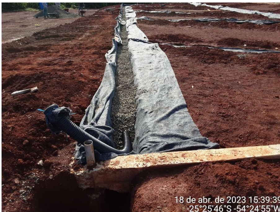
2ª MD – FOTO 08– TUBULAÇÃO SISTEMA DE DRENAGEM – GEOTEXTIL E DRENO
