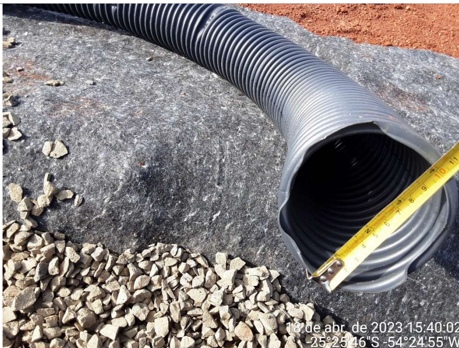
2ª MD – FOTO 07 – TUBULAÇÃO SISTEMA DE DRENAGEM – GEOTEXTIL E DRENO
