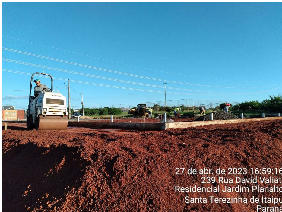
2ª MD – FOTO 09 – COMPACTAÇÃO E TERRAPLANAGEM
