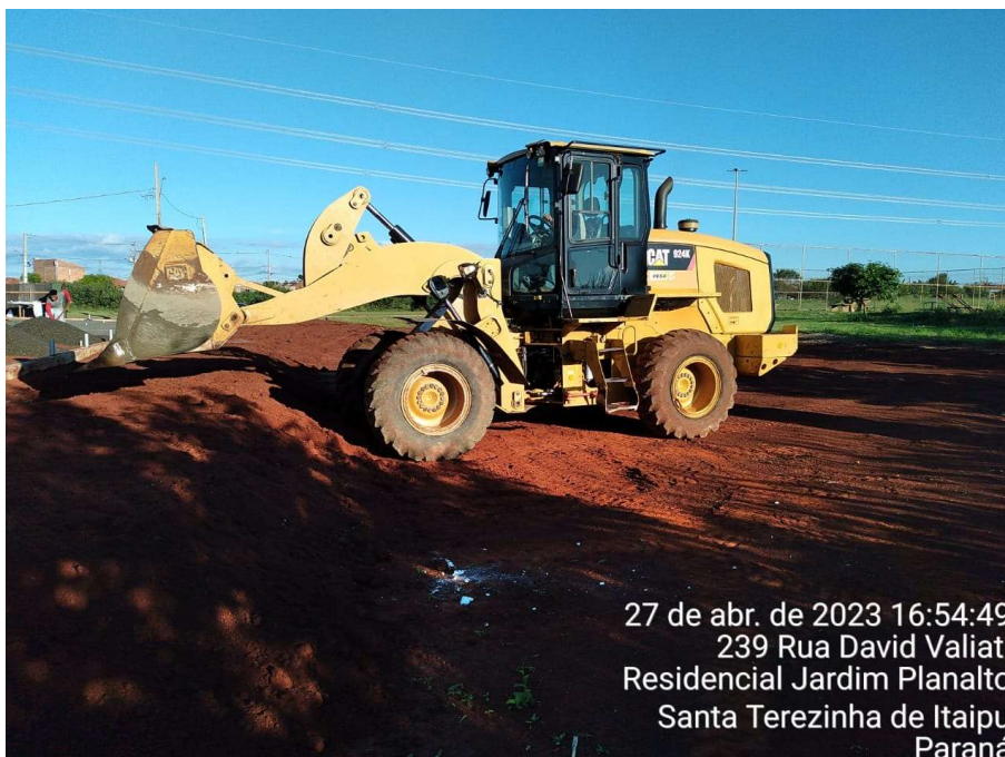
2ª MD – FOTO 14– MOVIMENTAÇÃO DE TERRA- ATERRAMENTO
