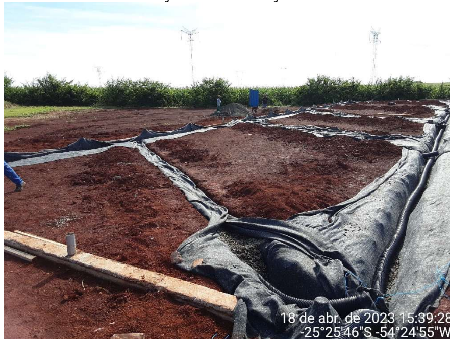
2ª MD – FOTO 06 – SERVIÇO DE INSTALAÇÃO DA IMPERMEABILIZAÇÃO
