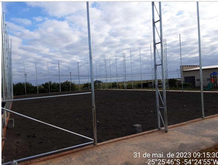
3ª MD – FOTO 07 – SERVIÇO DE INSTALAÇÃO DO ALAMBRADO
