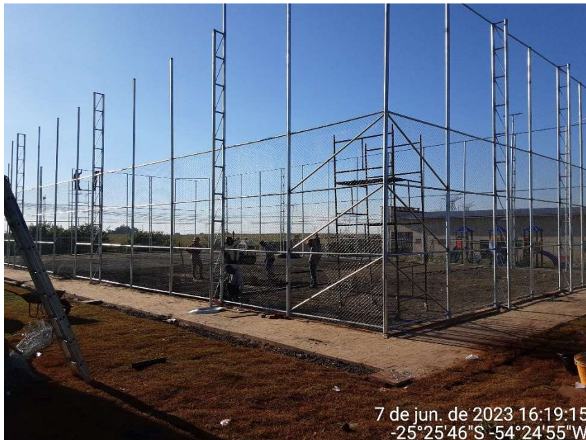
3ª MD – FOTO 13 – SERVIÇO DE INSTALAÇÃO DA TELA GALVANIZADA DO ALAMBRADO METÁLICO
