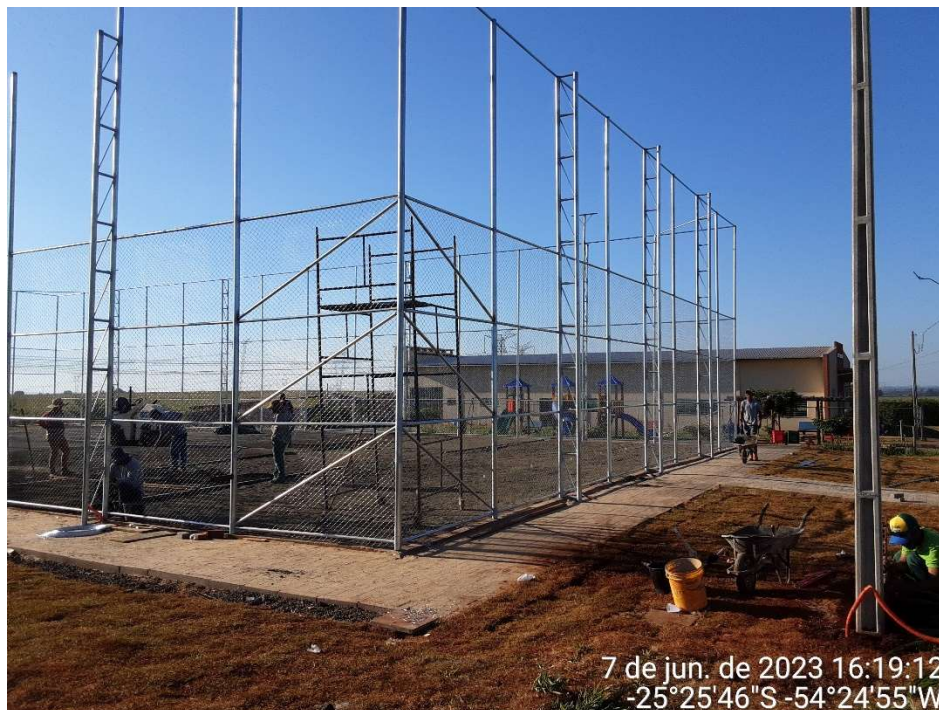
3ª MD – FOTO 11 – INSTAÇÃO POSTE PADRÃO E TELAS ALAMBRADO
